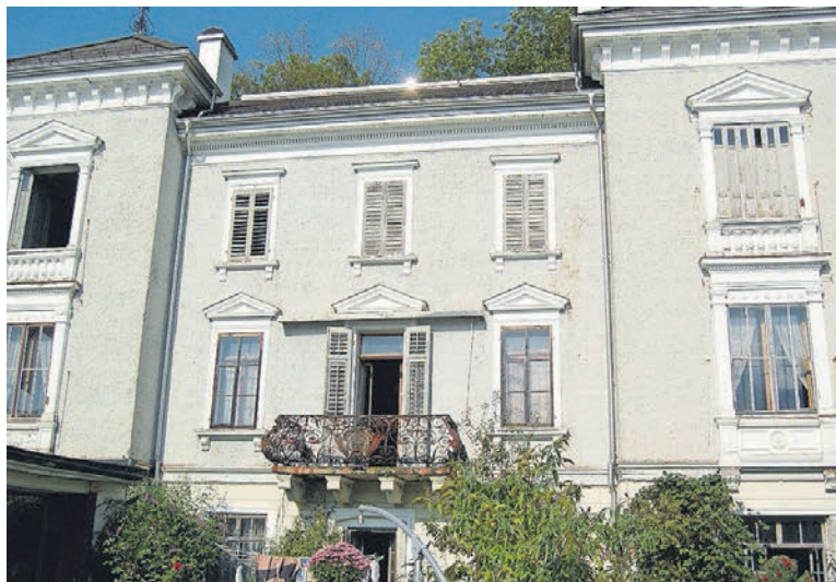
Villa Schoeck mit den beiden Blindfenstern im 2. Stock Richtung See
